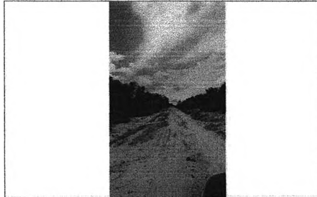
ESTRADA DE ACESSO AS UNIDADES ESCOLARES
