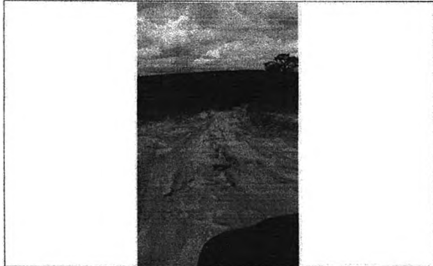
ESTRADA DE ACESSO AS UNIDADES ESCOLARES
