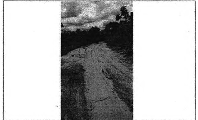
ESTRADA DE ACESSO AS UNIDADES ESCOLARES
