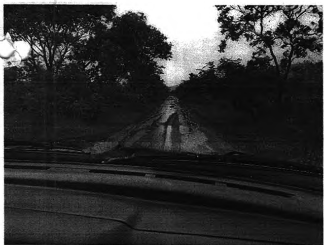
ESTRADA DE ACESSO AS UNIDADES ESCOLARES
