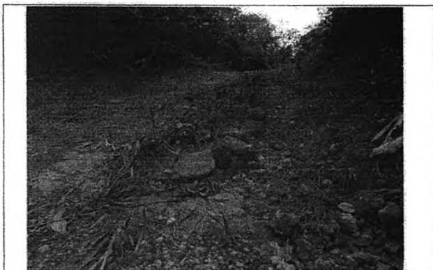
ESTRADA DE ACESSO AS UNIDADES ESCOLARES
