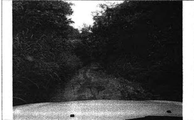
ESTRADA DE ACESSO AS UNIDADES ESCOLARES
