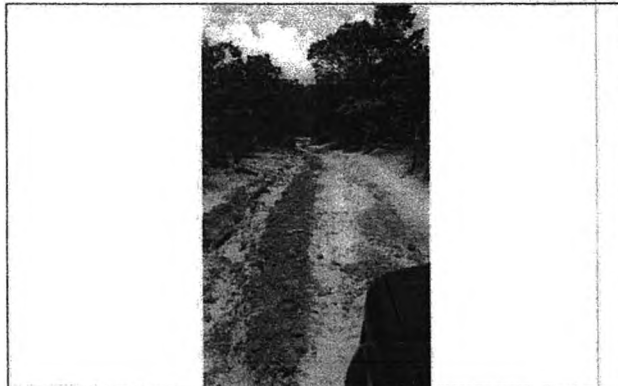
ESTRADA DE ACESSO AS UNIDADES ESCOLARES
