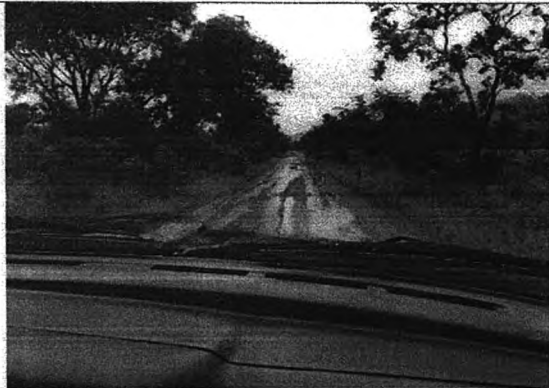
ESTRADA DE ACESSO AS UNIDADES ESCOLARES
