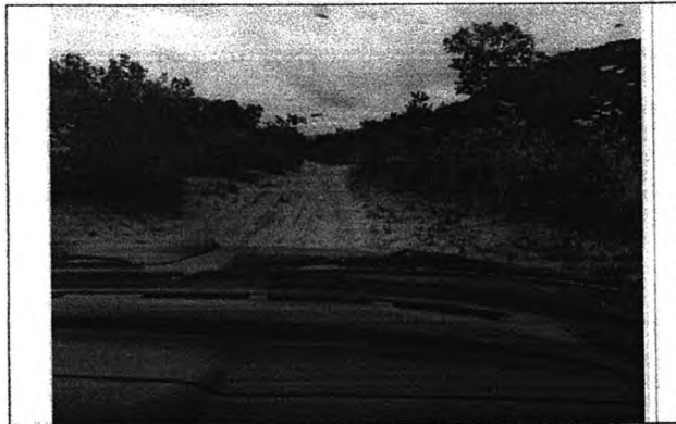
ESTRADA DE ACESSO AS UNIDADES ESCOLARES
