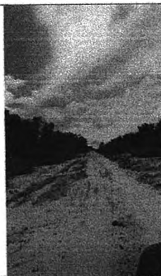
ESTRADA DE ACESSO AS UNIDADES ESCOLARES
