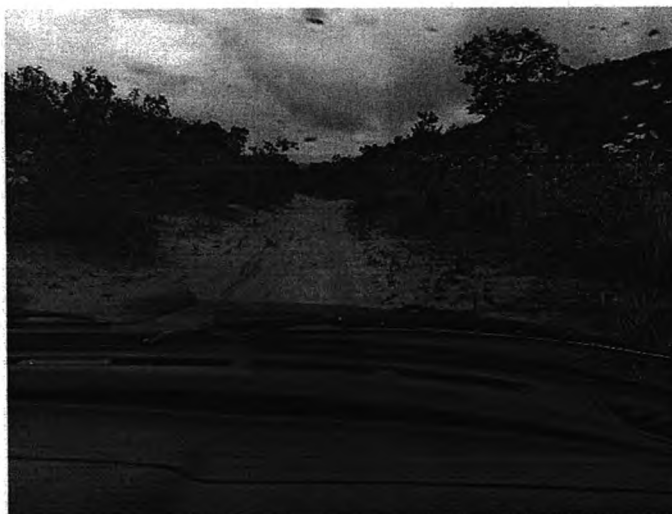
ESTRADA DE ACESSO AS UNIDADES ESCOLARES
