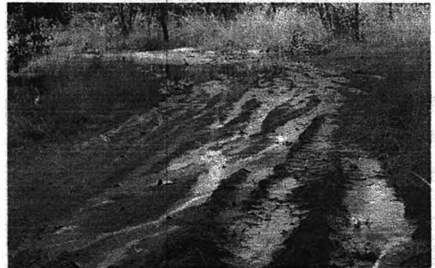
ESTRADA DE ACESSO AS UNIDADES ESCOLARES
