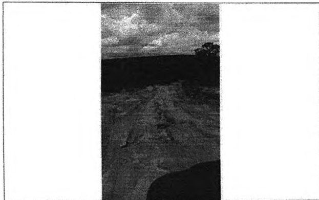
ESTRADA DE ACESSO AS UNIDADES ESCOLARES
