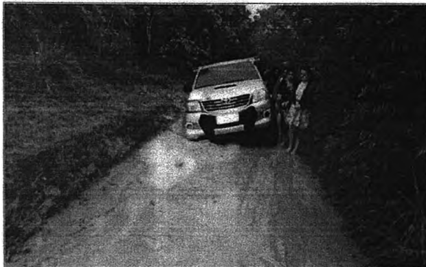
ESTRADA DE ACESSO AS UNIDADES ESCOLARES
