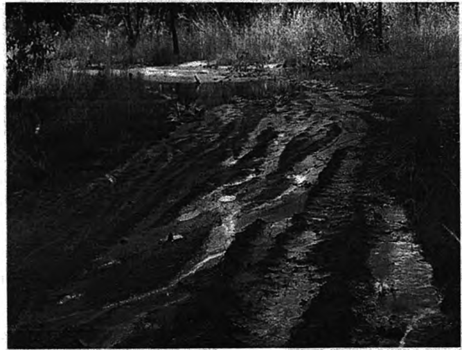
ESTRADA DE ACESSO AS UNIDADES ESCOLARES
