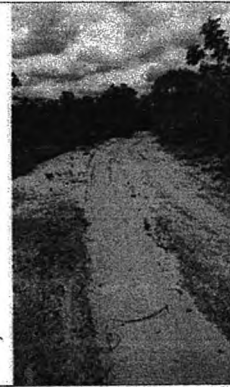
ESTRADA DE ACESSO AS UNIDADES ESCOLARES
